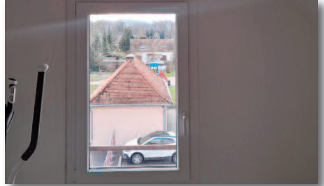
Remplacement de fenêtres dans un appartement communal
