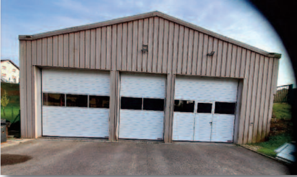
Remplacement des portes sectionnelles de l'atelier communal
