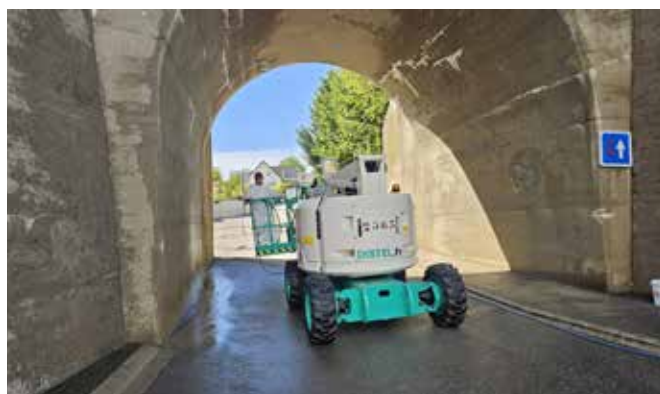
Travaux de nettoyage effectués en régie
