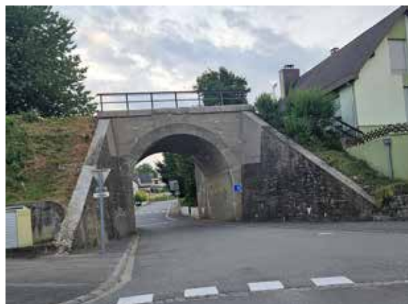
Pont avant travaux de nettoyage
